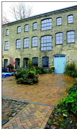
Das Hinterhaus-Gebäude im Hof Johannisstraße 48-50 wird jetzt zum Wohnen genutzt, die Fenster erinnern an die alten Stahlfenster.
