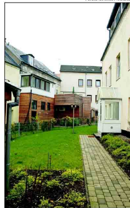
Schöner: Die Holzverkleidung des Anbaus im Hintergrund kam im Rahmen der Hofsanierung in der Bergstraße 1/Knuthstraße 26/ Duburger Straße 65 zustande.
