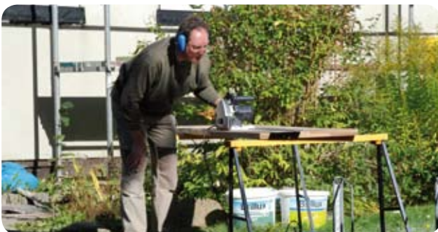
Endspurt für die Handwerker: Noch ist viel zu tun.
