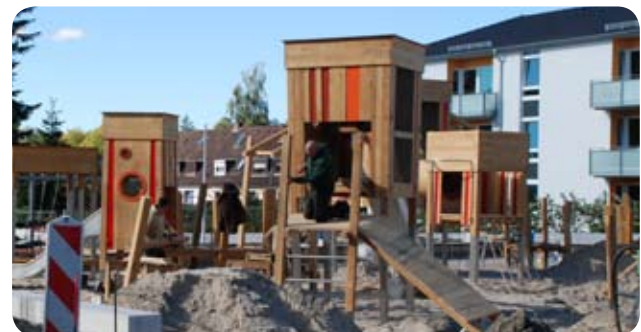
Bauarbeiten am Kinderspielplatz: Inzwischen ist alles fertig.
